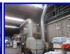
พื้นที่ตรวจวัด : ปอด Dust Collector
