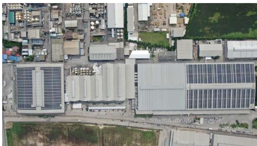
Solar Rooftop ที่อาคารคลังสินค้า 2 และคลังพัสดุ 2
